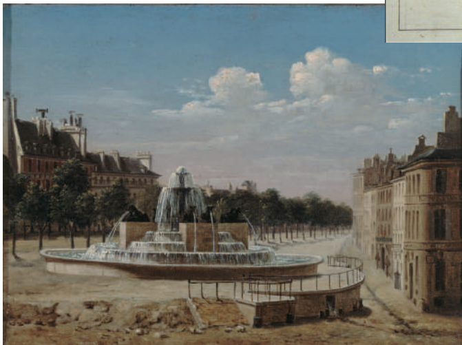
Fontaine du Château d'Eau 1850 rue de Bondy - Paris
