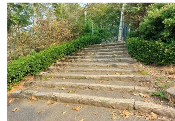
1 Requalification des escaliers marches en béton
