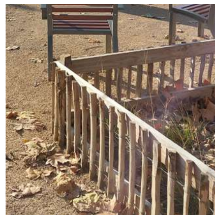
6 Ganivelles renforcées de protection des plantations
