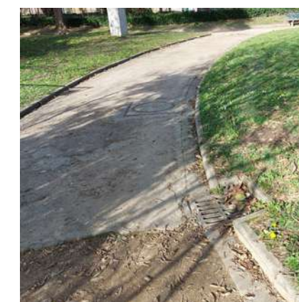
1 Reprise d'une partie des caniveaux béton
