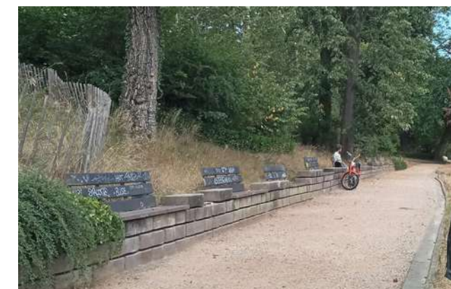
3 Reprise du mur de soutènement et assises
