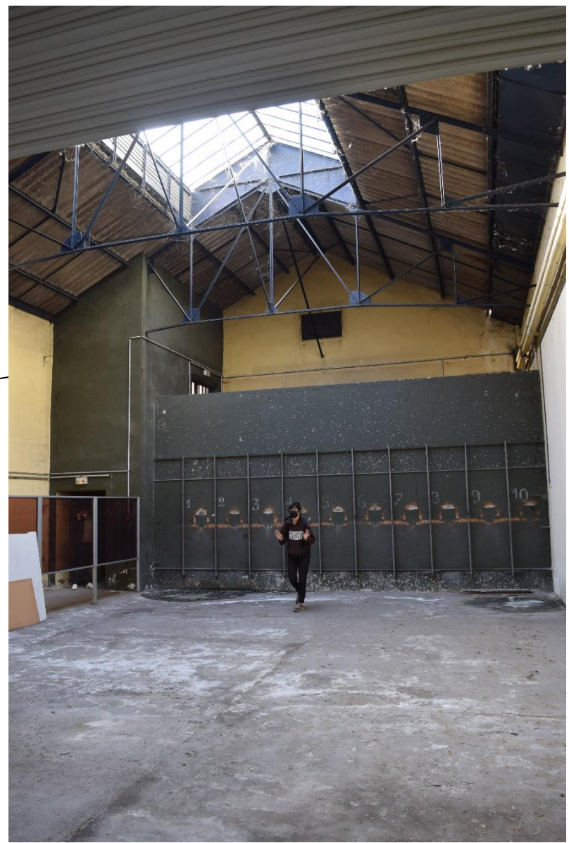
Les stands de tir de l'ancienne chaufferie
