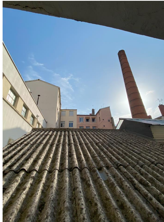
Toiture amiantée (en dépollution) et cheminée patrimoniale
