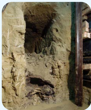
Galerie romaine en cours de dégagement et de confortement sous les pentes de la Croix-Rousse
