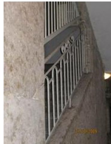
Un mur ajouré souvent réduit à 2 piliers
