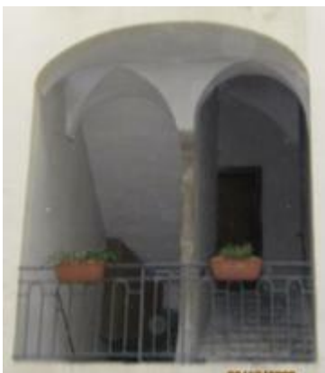
Plein (7, rue Puits Gaillot / 4, rue Désirée) - Paliers sur voutes en arêtes
