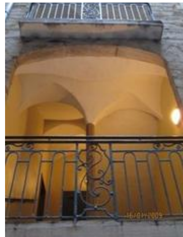
5, rue Sainte-Marie des Terreaux
