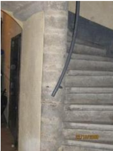
un pilier (escalier à vis)
